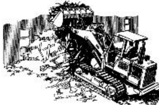
Chargeuse sur chantier de démolition
