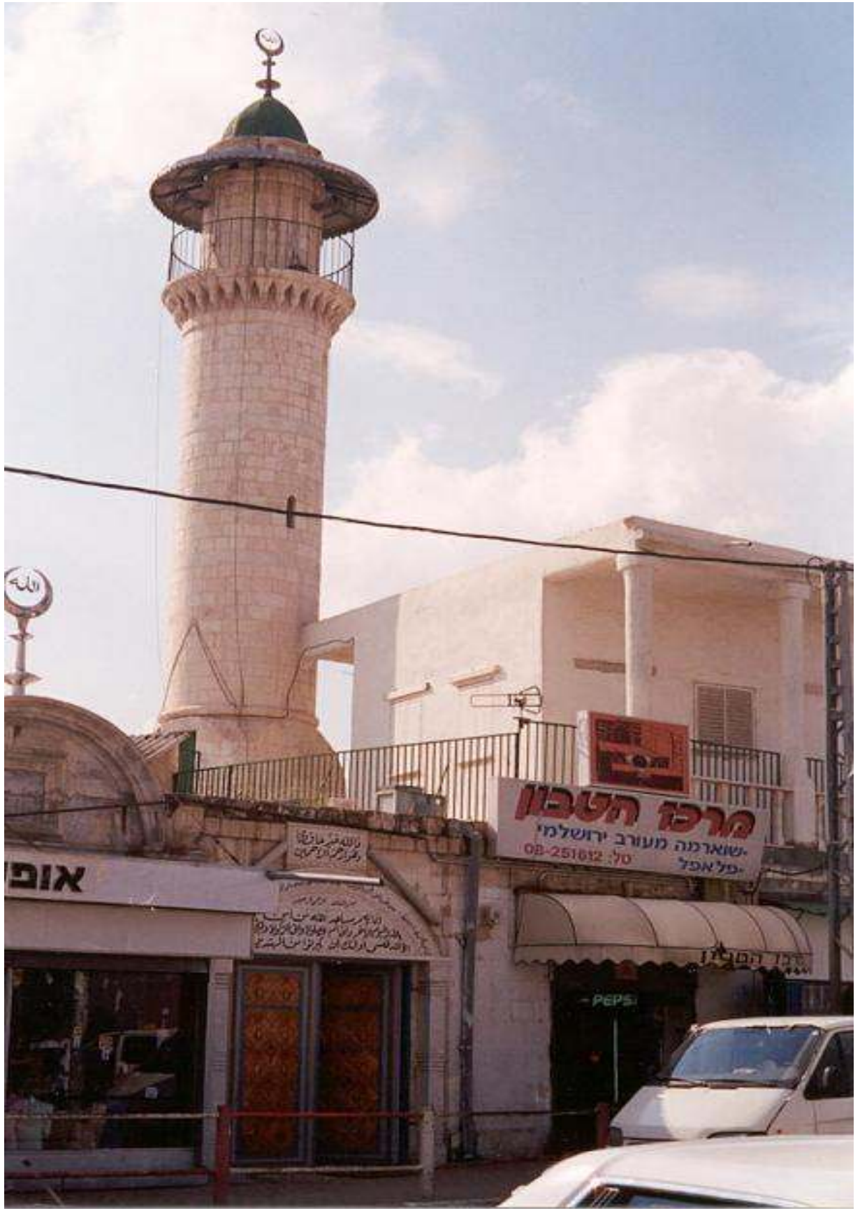
جامع دهمش بعد الترميم وقربه محطة الباصات
